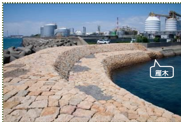
写真-2 高砂港向島突堤・西防波堤
