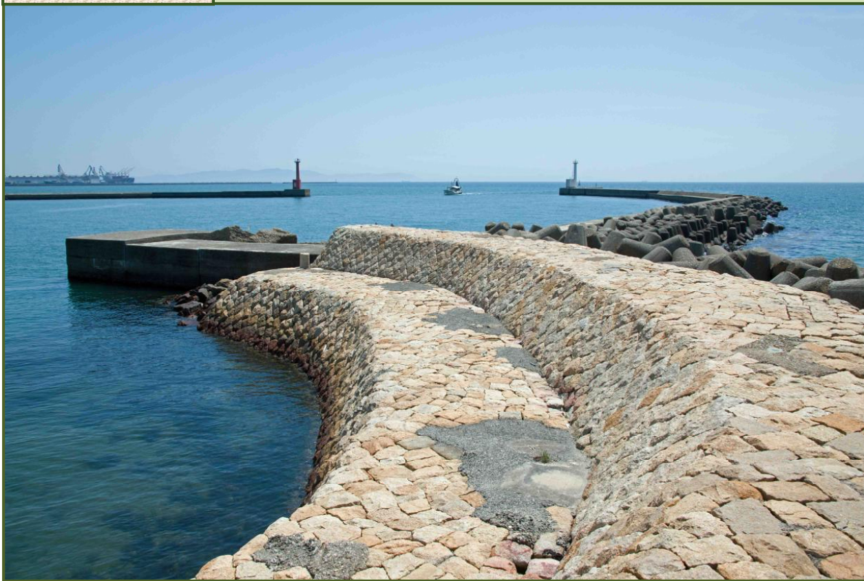
写真-1 高砂港向島突堤・西防波堤（令和6年4月撮影）
