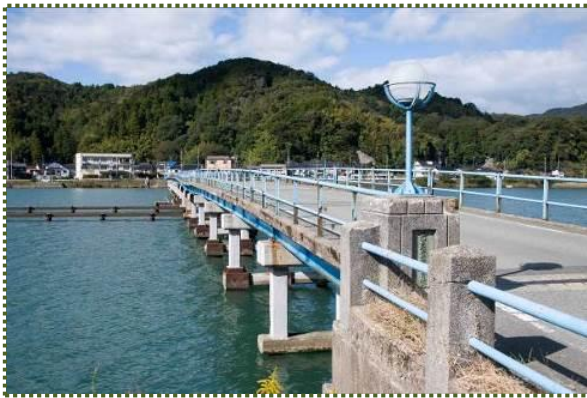
写真-8 現・城崎大橋（右岸から撮影）
