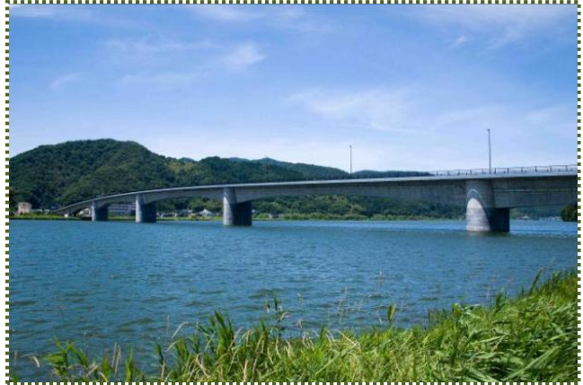
写真-10 完成した城崎大橋（令和8年7月撮影）
