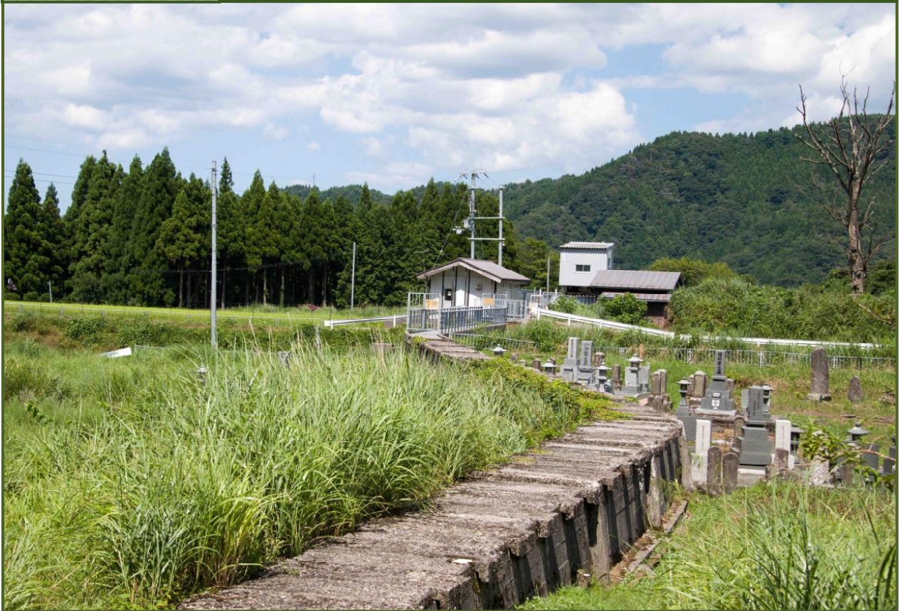
写真-1 青下の用水路（令和6年8月撮影）
