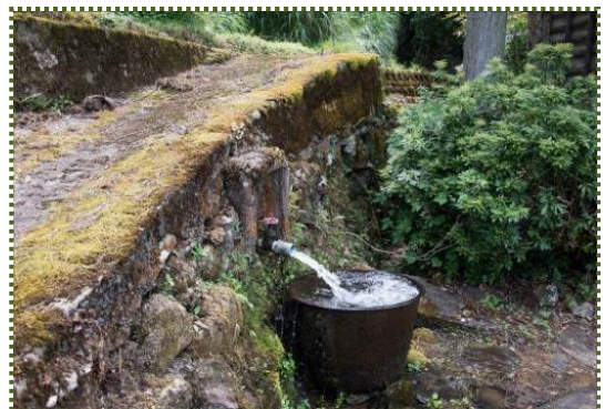
写真-3 用水路から取水するためのバルブ
