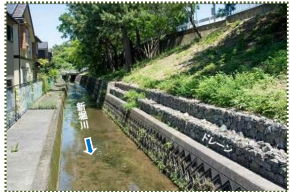
写真-9 樋ノ口町 2 丁目付近の武庫川堤防のドレーン
