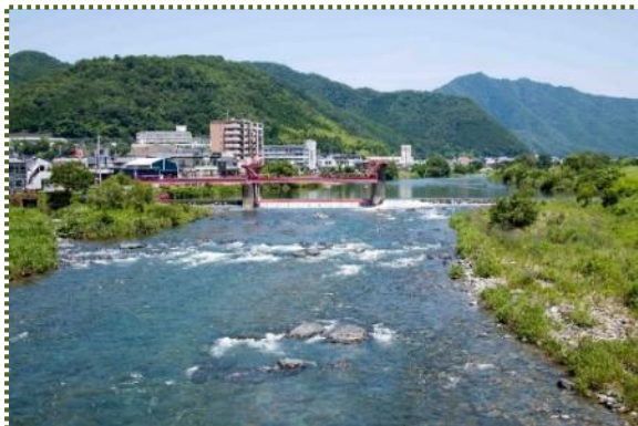
写真-6 河東大橋から上流の荒井頭首工を撮影
