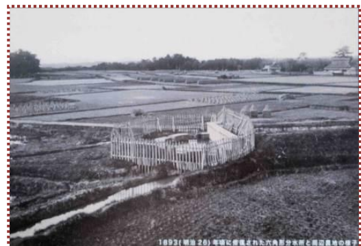
写真-5 明治 24（1891）年に造られた練部屋分水所 （東播磨水土地改良区パンフレットから引用）
