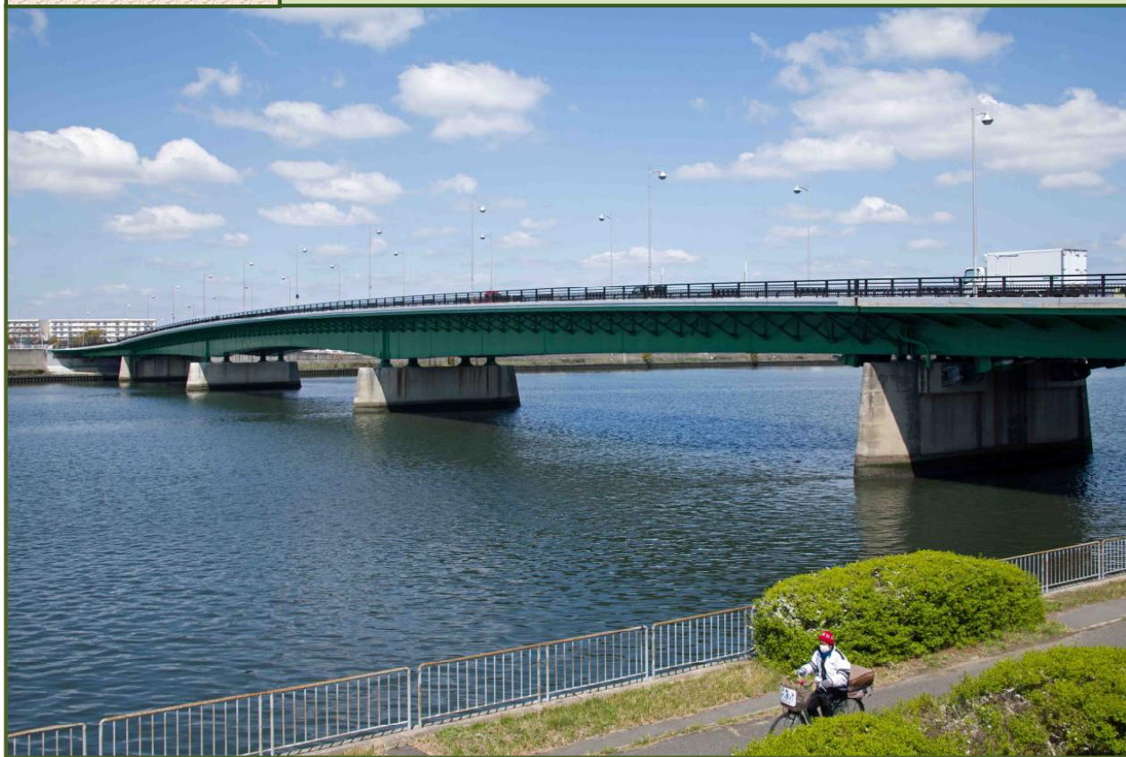
写真-1 神崎川左岸から神崎橋を撮影（令和4年4月）
