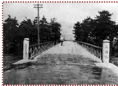
写真-6 初代神崎橋 大正期の神崎橋 (大阪市HP「橋の紹介」から引用)
