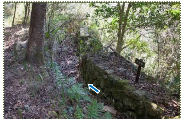
写真-7 水車への導水路跡
