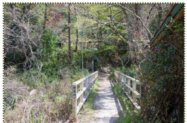
写真-2 住吉川に架かる東谷橋を右岸側から撮影
