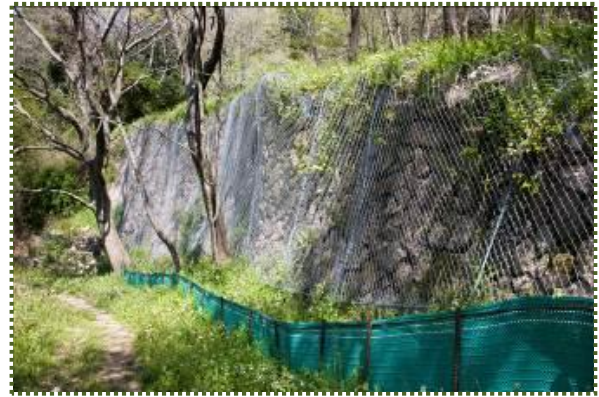
写真-4 落石防護網で覆われた石積み擁壁
