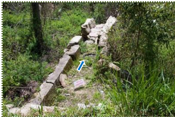
写真-11 滝壺の排出口から続く水路
