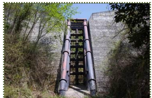
写真-8 2号地近くにある透過型砂防堰堤
