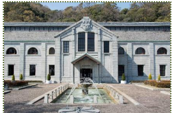
写真-7 神戸市水の科学博物館 （奥平野浄水場（旧）急速ろ過場上屋）
