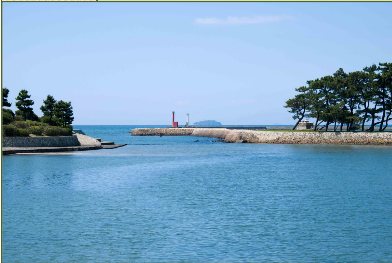
写真-1 高砂港向島突堤・東防波堤を望む（令和6年年4月撮影）
