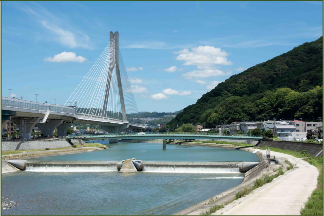
写真-1 国道 176 号呉服橋から猪名川に架かるビッグハープを撮影（平成 27 年 7 月）
