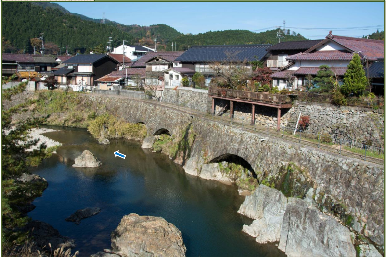
写真-1 姫宮橋から市川右岸のトロッキ軌道跡を撮影（2014年11月）
