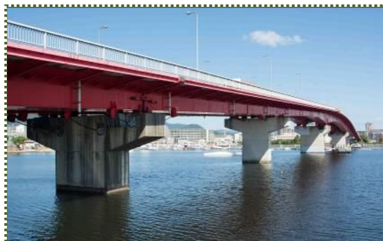
写真-2 西宮大橋
