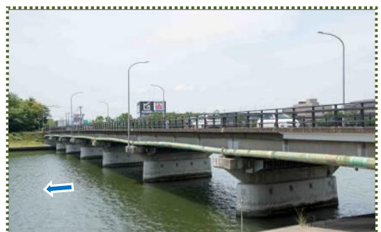
写真-3 国道 250 号・汐見橋
