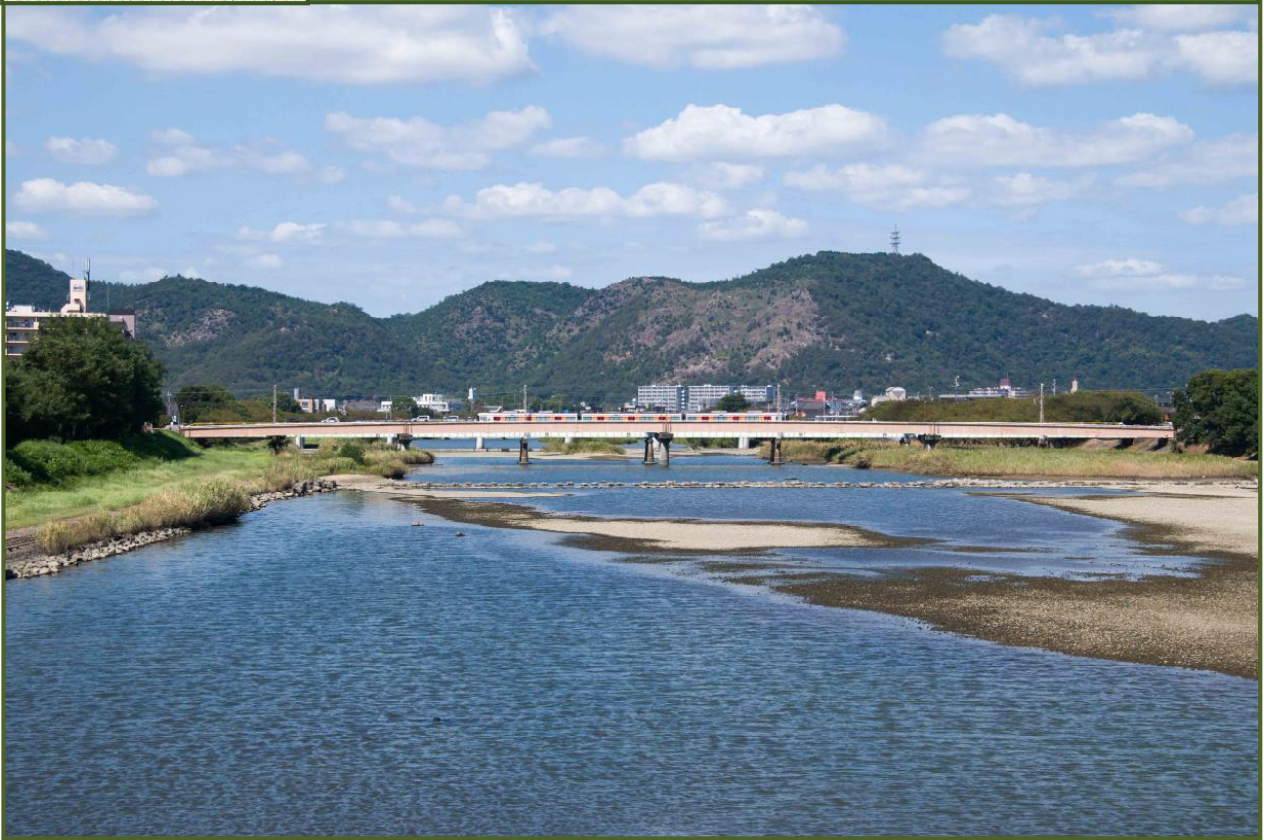
写真-1 国道 250 号・汐見橋から上流方向を撮影（令和 6 年 6 月）
