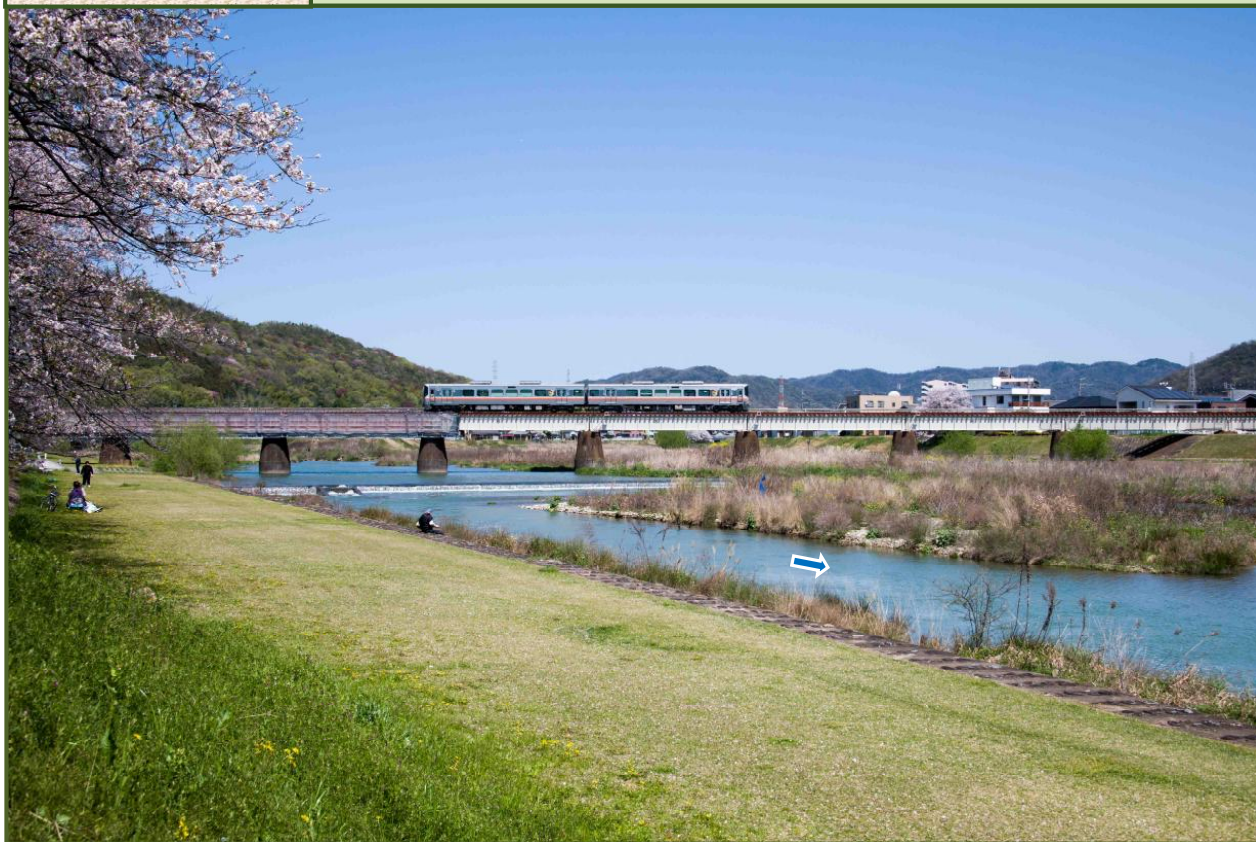
写真-1 夢前川右岸から JR 姫新線・夢前川橋梁を撮影（令和6年4月）
