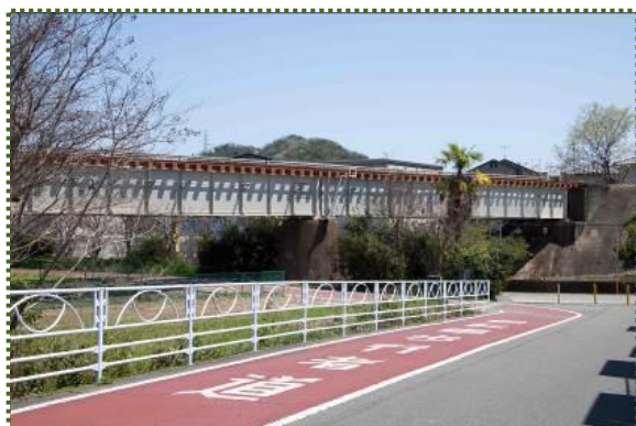
写真-2 左岸堤内側の JR 姫新線・夢前川橋梁
