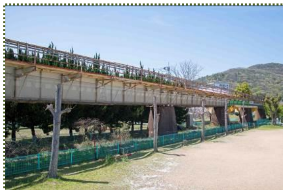
写真-3 右岸堤内側の JR 姫新線・夢前川橋梁
