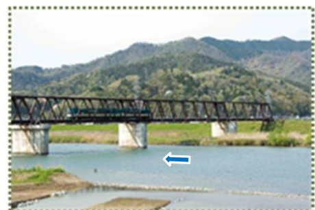
写真-3 京都丹後鉄道宮豊線・円山川橋梁
