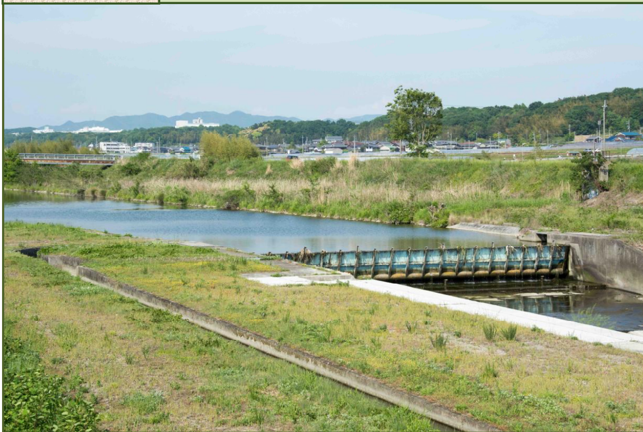
写真-1 林崎掘割水路の起点・西戸田統合井堰（令和元年5月撮影）
