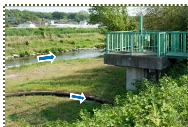
写真-4 伏樋に代わり取水樋門から堤内へ
