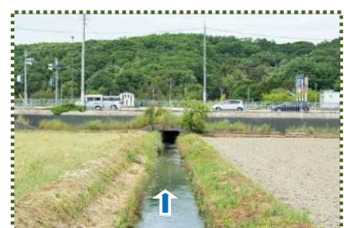
写真-6 国道 175 号の下を暗渠で抜ける
