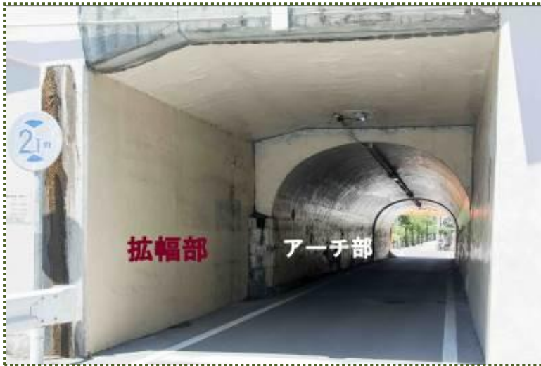
写真-3 奥に見えるのがアーチ部で手前が拡幅部
