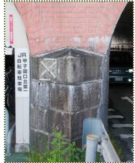
写真-4 橋脚北側（上流側）の三角柱状の水切り
