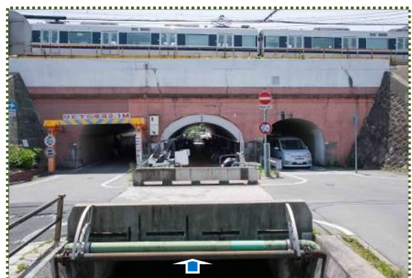
写真-2 新堀川避溢橋（北面）
