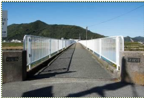
写真-9 旧坂越橋（左岸側から撮影）
