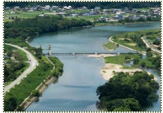
写真-5 可動堰に改築された木津井堰
