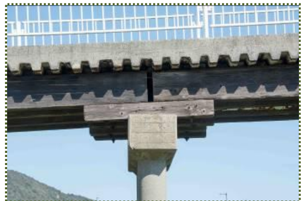
写真-10 右岸高水敷部の木製桁
