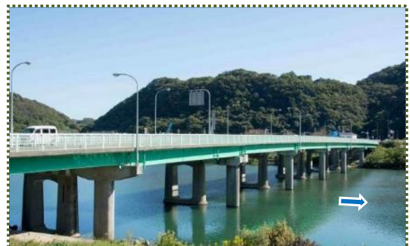
写真-11 坂越橋（令和元年11月 右岸下流側から撮影）
