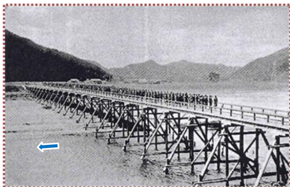
写真-7 旧・旧坂越橋
