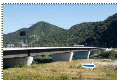
写真-12 坂越大橋
