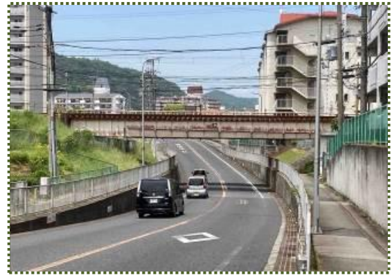
写真-4 右岸堤内側の夢前川橋梁
