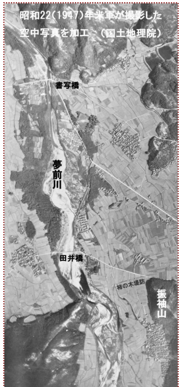
写真-5 書写橋下流の夢前川の状況
