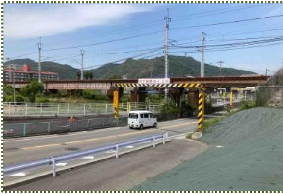
写真-3 左岸堤内側の夢前川橋梁
