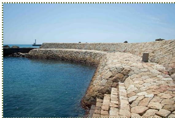
写真-2 高砂港向島突堤・西防波堤と雁木（手前）
