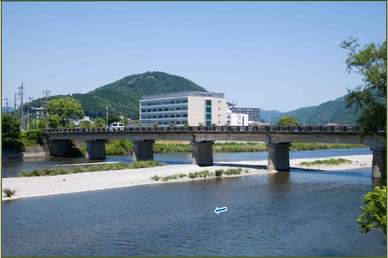
写真-1 揖保川左岸から宍粟橋および宍粟市役所を望む(令和3年6月撮影)
