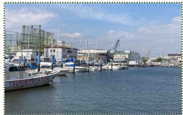
写真-4 開削された水路が現在の今津港
