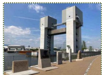
写真-6 完成した新川・東川統合水門
