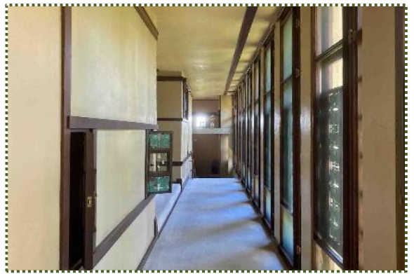
写真-11 大きなガラス窓がある3階西側の廊下
