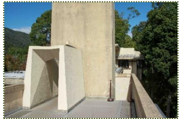
写真-16 4階バルコニー（食堂の南側）
