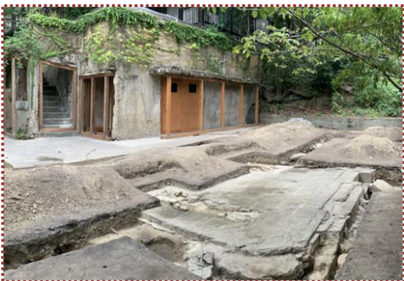
写真-17 大谷石が敷き詰められた廊下跡
