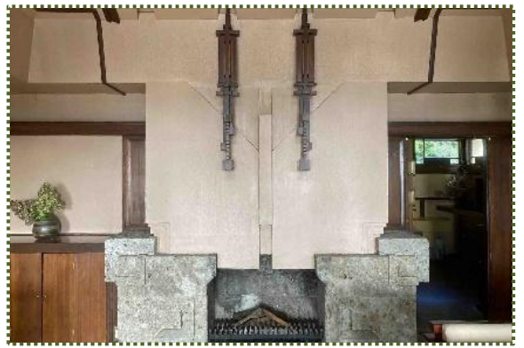
写真-13 4階食堂の大谷石の暖炉（右の扉奥は厨房）
