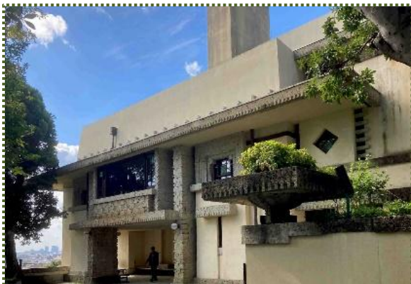
写真-5 玄関へのアプローチ
