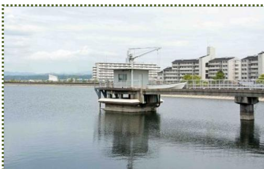
写真-9 野々池貯水池の取水塔
