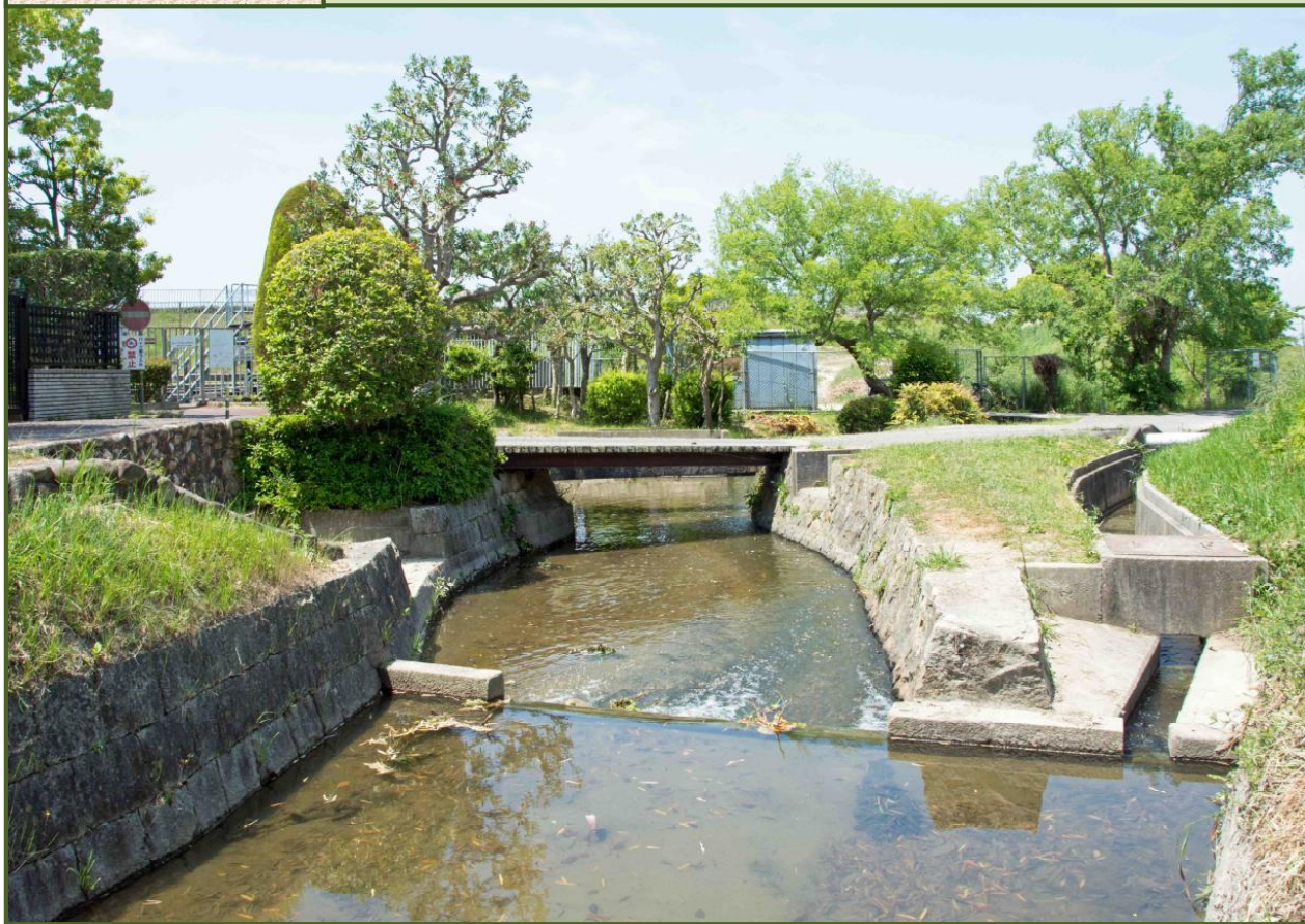
写真-1 林崎掘割水路の末端部（令和元年5月撮影）
