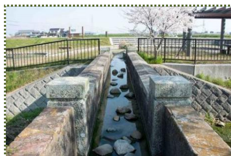
写真-6 掌中橋水路を手中流の左岸側から撮影
