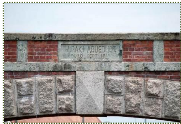
写真-3 西側面の扁額 「HIRAKI AQUEDUCT BUILT SEPT 1915」
