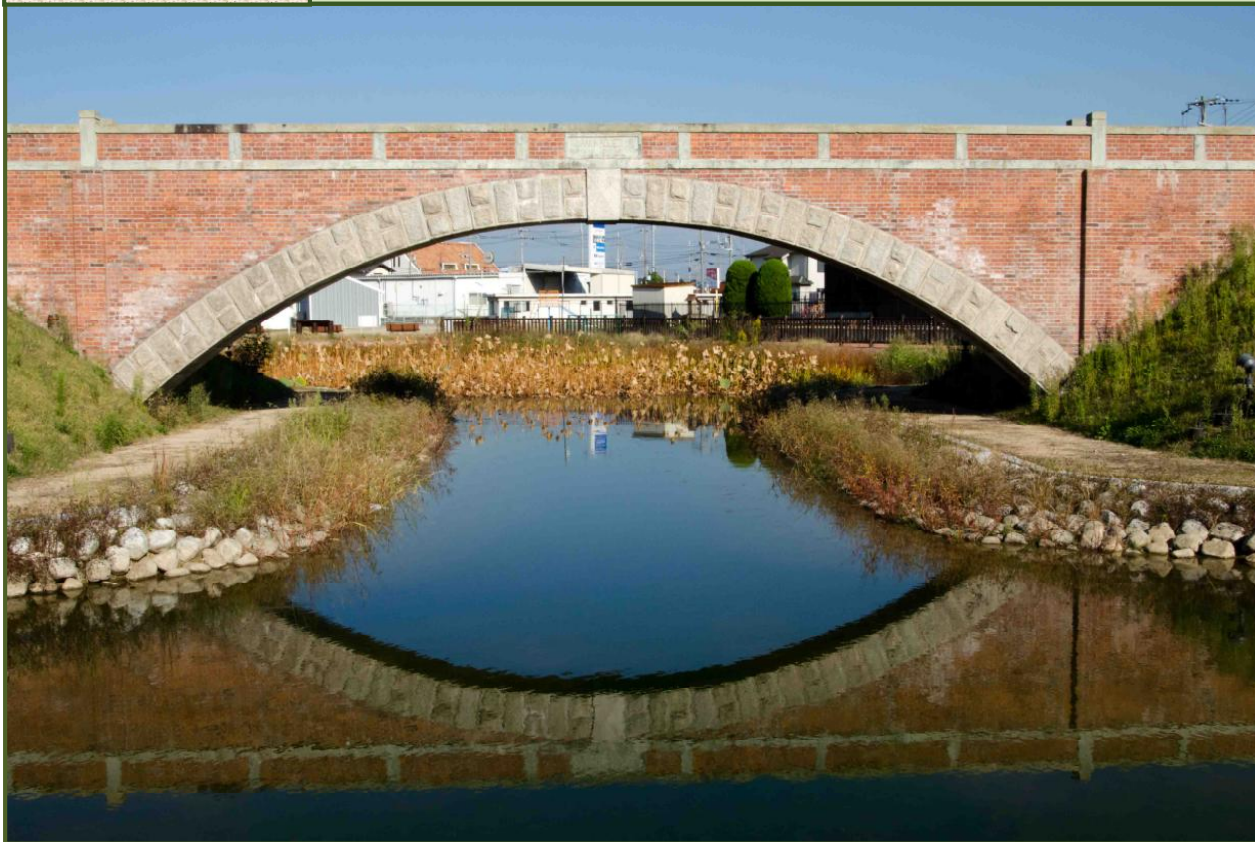
写真-1 花崗岩の輪石と赤煉瓦のコントラストが美しい平木橋（平成 24 年 10 月撮影）
