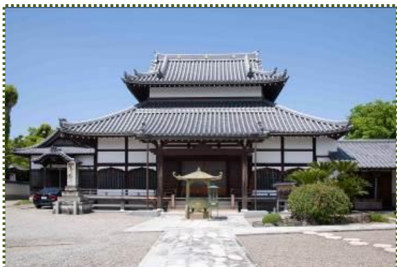
写真-4 清水口跡の西隣にある青蓮寺
