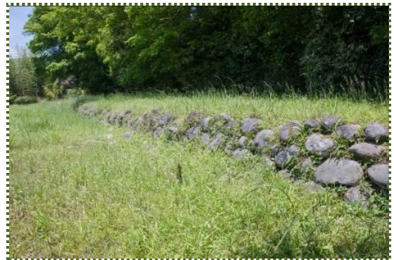
写真-10 下座場跡（右手が損保川堤防）
