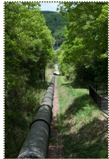
写真-8 南側斜面に敷設された サイフン管
