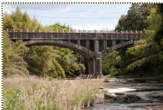
写真-2 下流側の御坂サイフォン橋（平成23年撮影）
