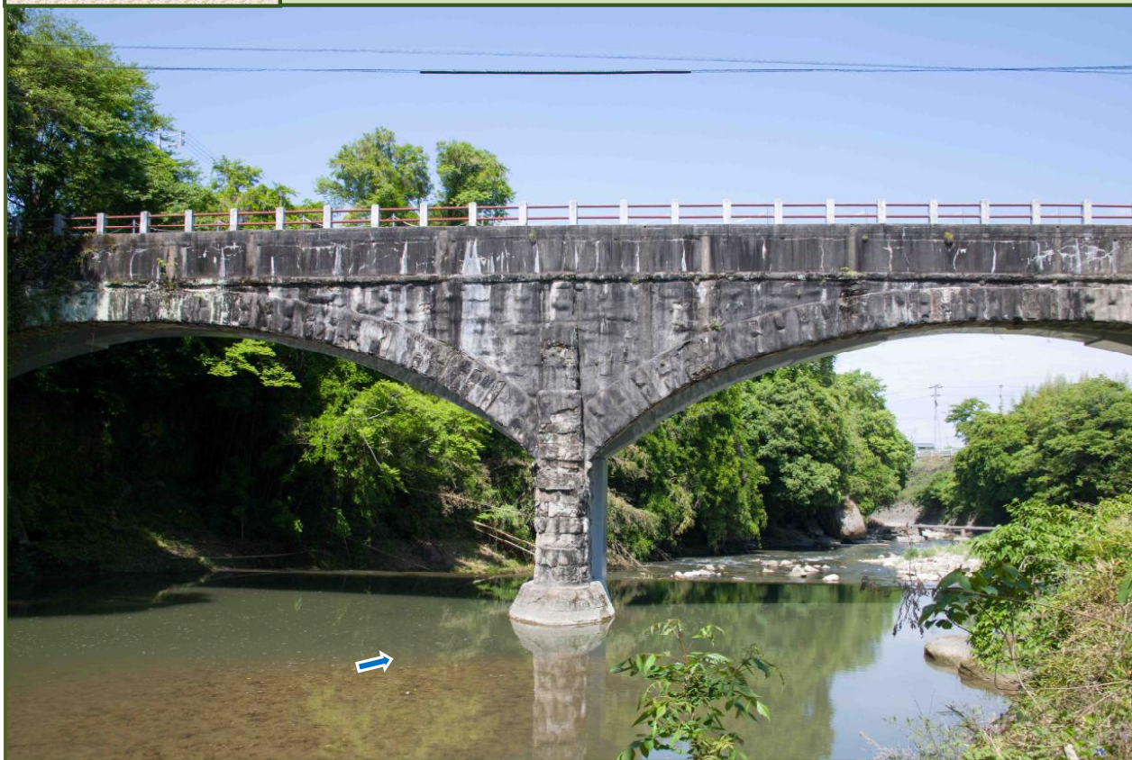
写真-1 志染川右岸から上流側の御坂サイフォン橋「眼鏡橋」を撮影（令和4年5月）
