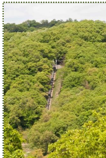
写真-7 北側斜面に敷設された サイフン管
