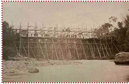
写真-10 御坂サイフォン工事 (博物館展示写真から引用)
