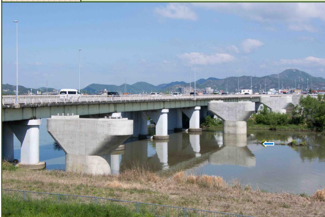
写真-1 国道2号・加古川橋架け替え工事（令和5年4月撮影）
