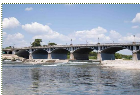
写真-7 武庫川に架かる国道 2 号・武庫大橋（尼崎市・西宮市）
