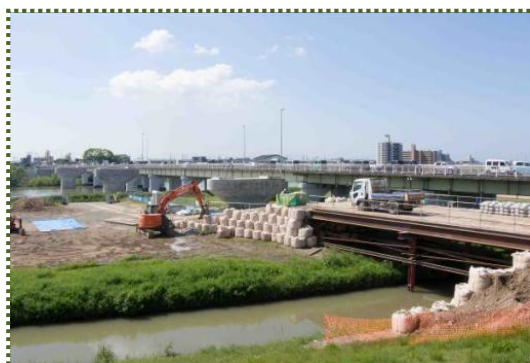
写真-2 加古川右岸堤防から加古川橋を撮影（令和5年4月）
