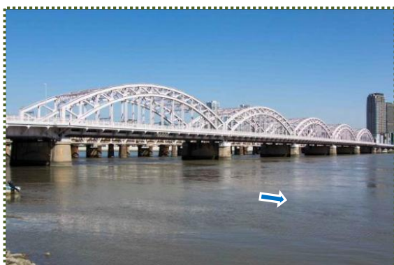
写真-6 淀川に架かる国道 176 号・十三大橋（大阪市）
