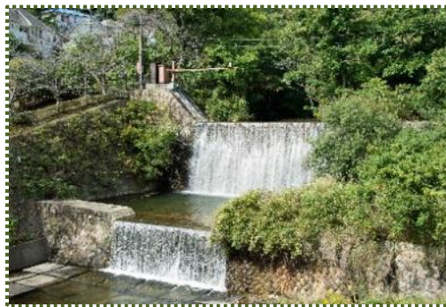
写真-2 河原毛堰堤
