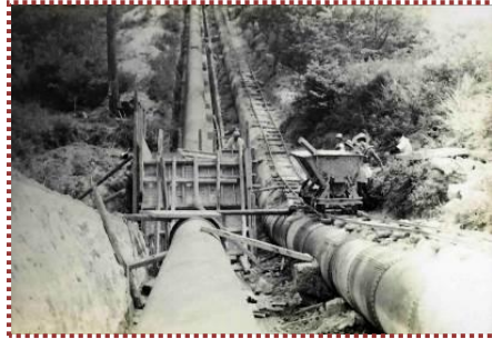
写真-3 二代目サイフォン管の設置工事の状況
