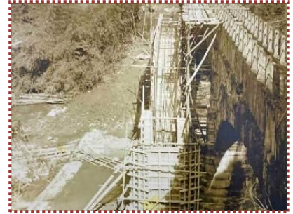
写真-4 二代目眼鏡橋の施工状況
