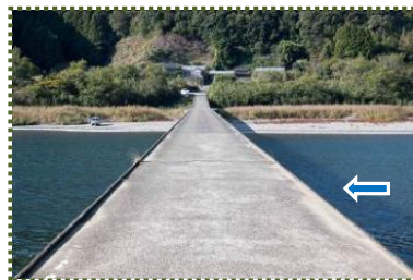
写真-10 佐田沈下橋 (W=4.2m)
