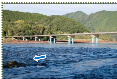
写真-9 佐田沈下橋 (L=291.6m)
