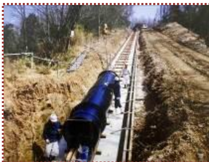
写真-5 ダクトイル鋳鉄管の据付状況 (博物館展示写真から引用)
