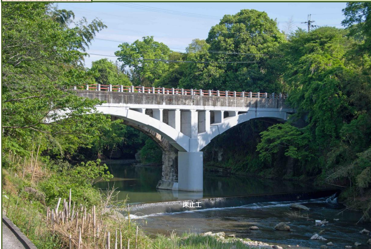
写真-1 御坂サイフォン橋「二代目眼鏡橋」を撮影（令和4年5月）
