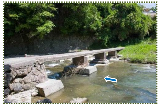
写真-8 眼鏡橋下流の沈下橋
