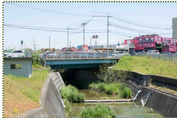
写真-6 国道 2 号・大町橋下を流れる谷八木川
