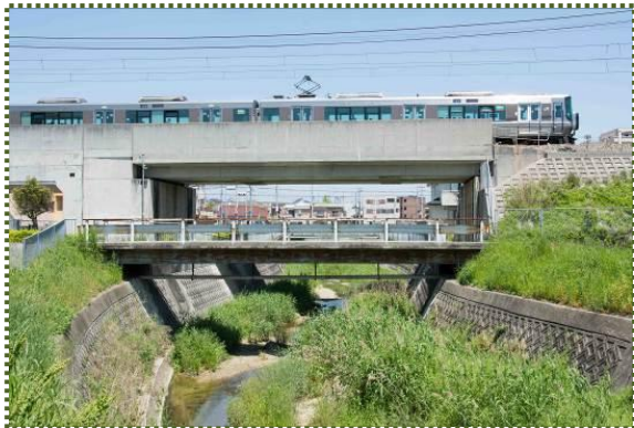
写真-5 谷八木川に架かる JR 山陽本線・東川橋梁
