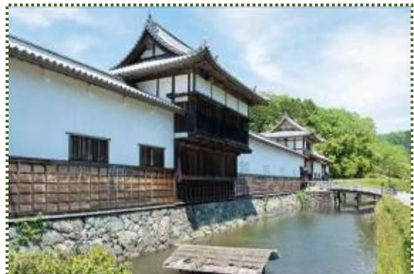
写真-3 乃井野陣屋跡（南側）
