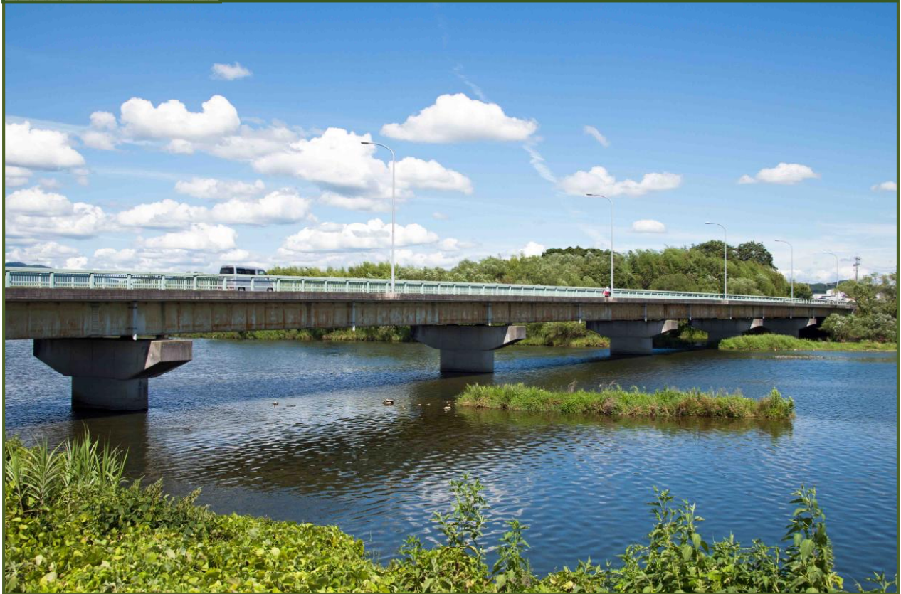
写真-1 市川右岸堤防から大礼橋を撮影（令和5年8月）
