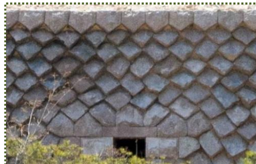
写真-2 白水川砂防堰堤の鎧積（拡大）
