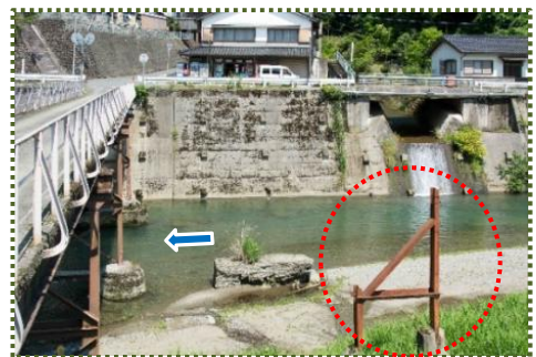
写真-8 流木から橋脚を守るための木除杭
