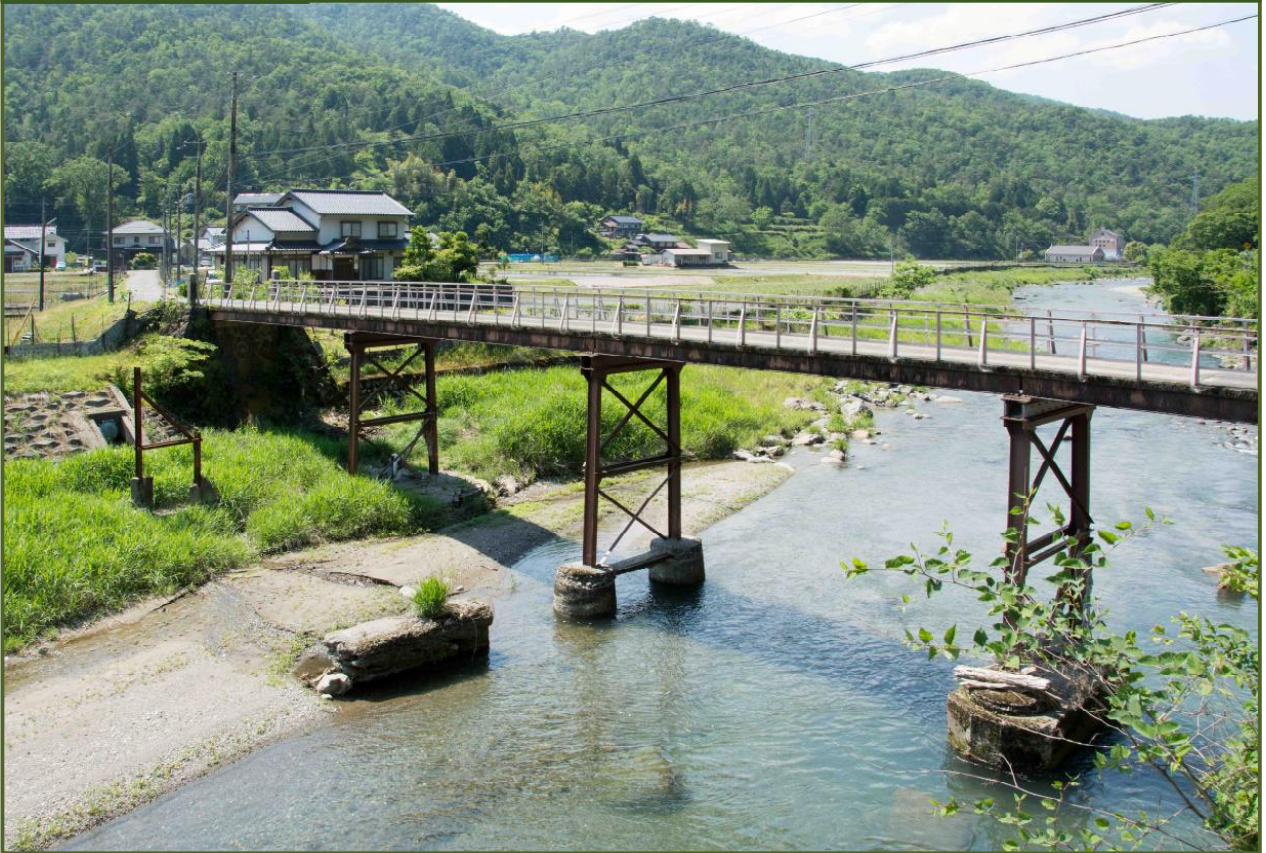
写真-1 大屋川に架かる樽見橋（平成30年5月撮影）
