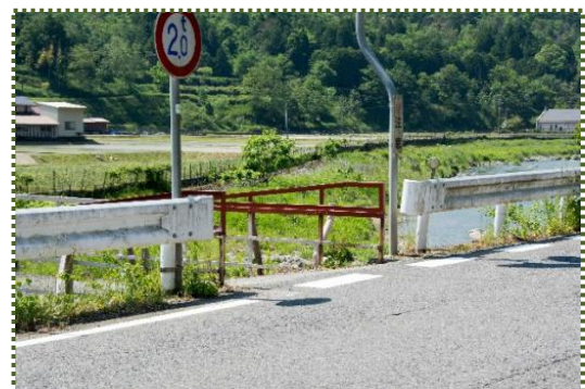
写真-5 県道と樽見橋との取り付け部
