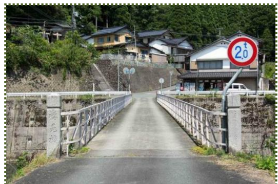
写真-2 樽見橋左岸側から右岸側を望む
