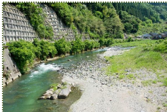
写真-12 樽見橋から上流を撮影（平成 26 年 4 月撮影）
