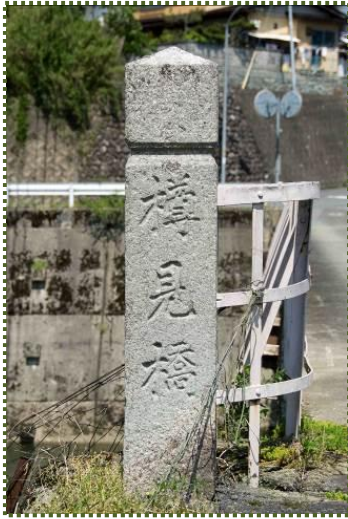
写真-6 左岸下流側の親柱
