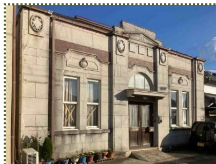
写真-9 明治 29 年に建てられた 旧東播銀行大門支店
