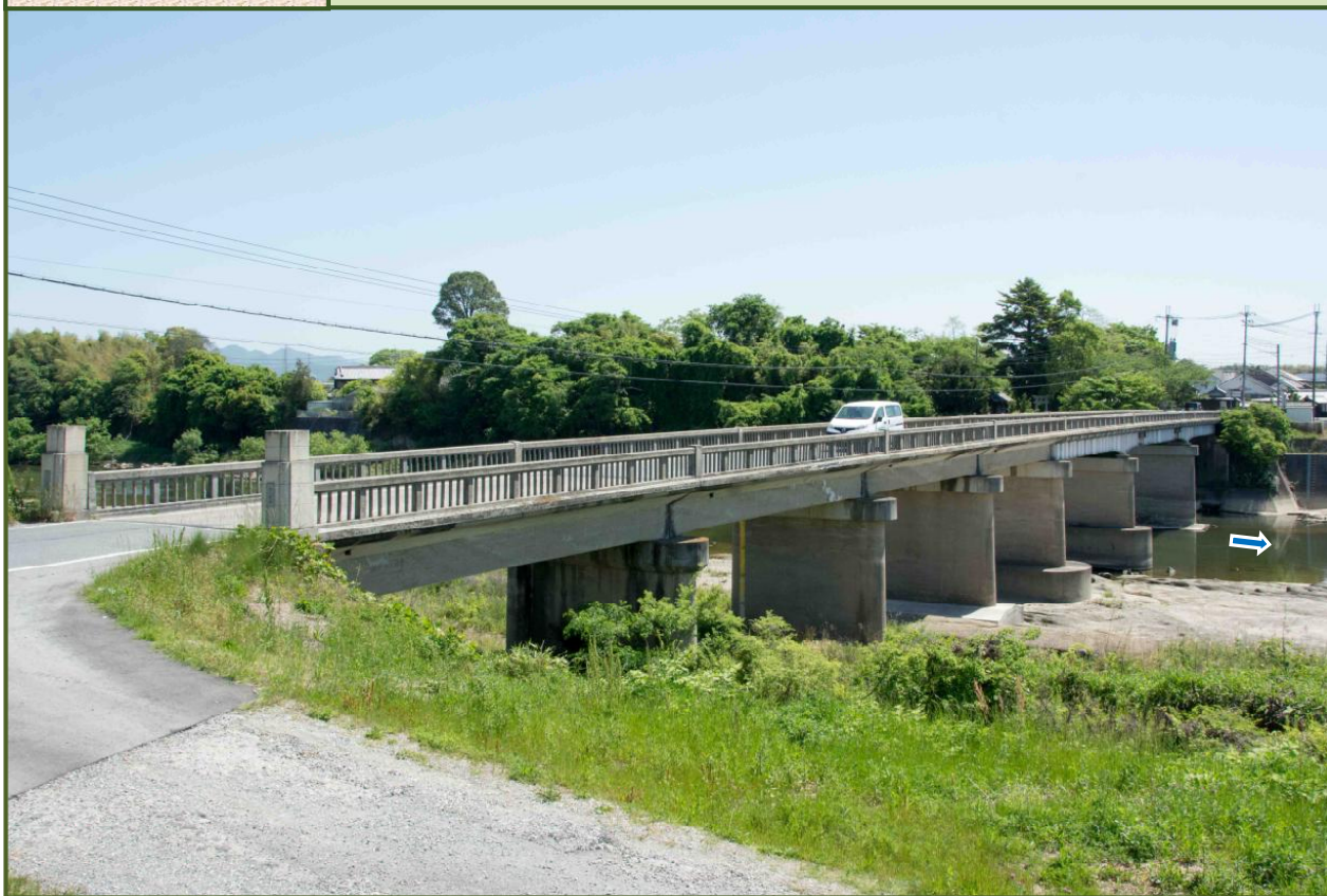
写真-1 加古川に架かる大門橋（令和2年5月撮影）
