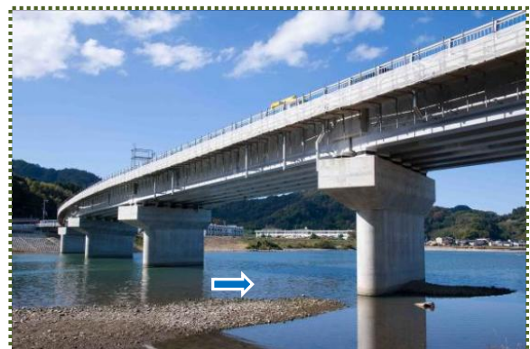
写真-7 （新）矢田橋（令和5年10月撮影）
