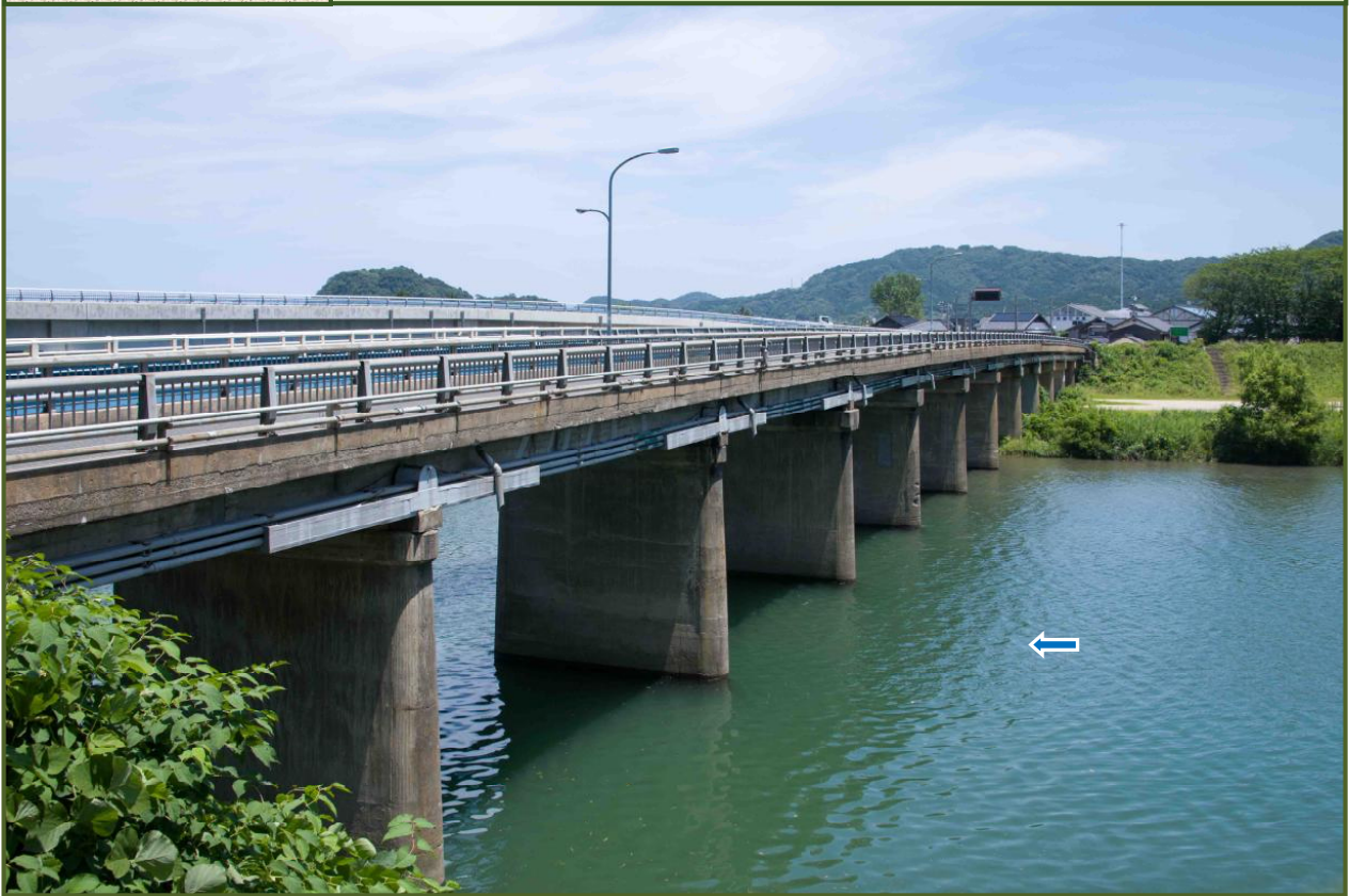
写真-1 矢田川に架かる矢田橋（令和5年6月撮影）
