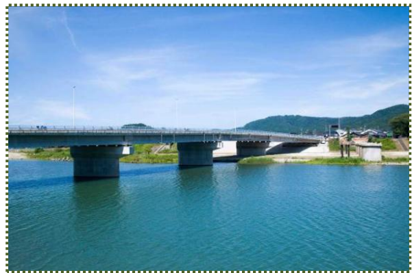
写真-9 (新) 矢田橋 (令和 8 年 7 月撮影)
