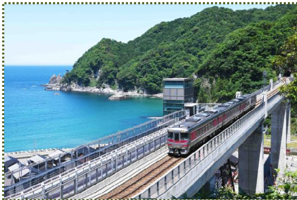
写真-10 余部橋梁
