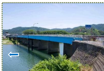
写真-5 矢田橋側道橋（左岸から撮影）
