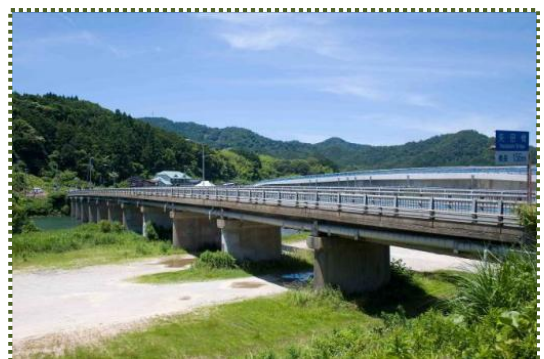
写真-2 矢田川右岸から矢田橋を撮影
