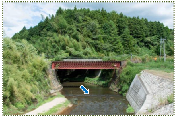
写真-7 沖田川に架かる山口線・徳佐川橋梁（平成30年8月撮影）
