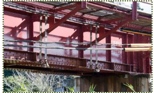
写真-4 竹野川橋梁第5連の腹板補強状況
