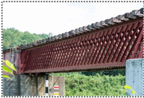
写真-5 竹野川橋梁第4連のラティス桁
