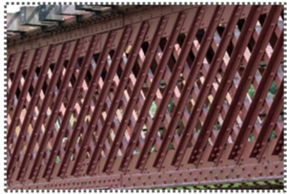
写真-6 ラティス桁のリベットによる接合状況
