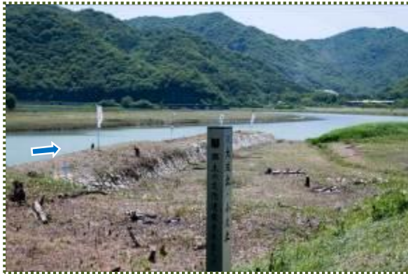
写真-2 千種川右岸堤防から大波止を撮影
