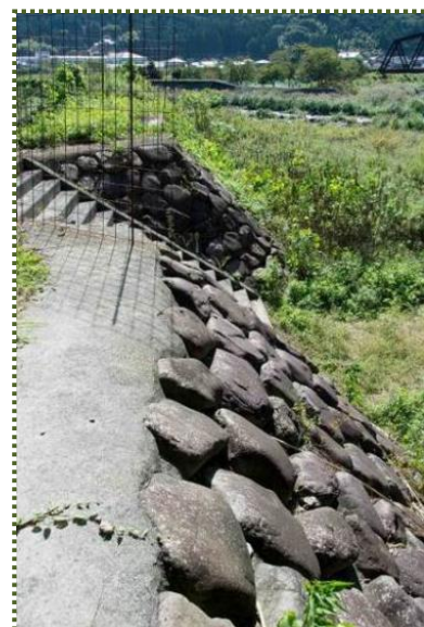
写真-2 現在の柳野呂堤防
