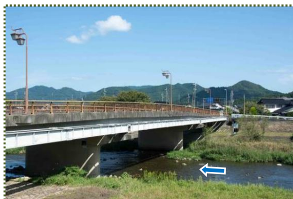
写真-7 円山川に架かる加都橋
