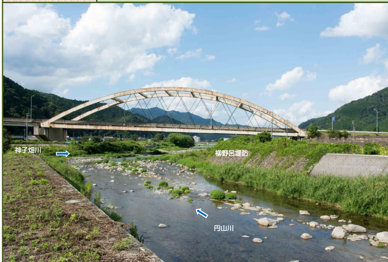
写真-1 円山川左岸堤防から朝来虹大橋を撮影（令和元年8月）
