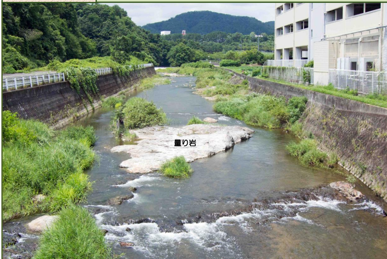
写真-1 紫合橋から量り岩を撮影（令和元年7月）
