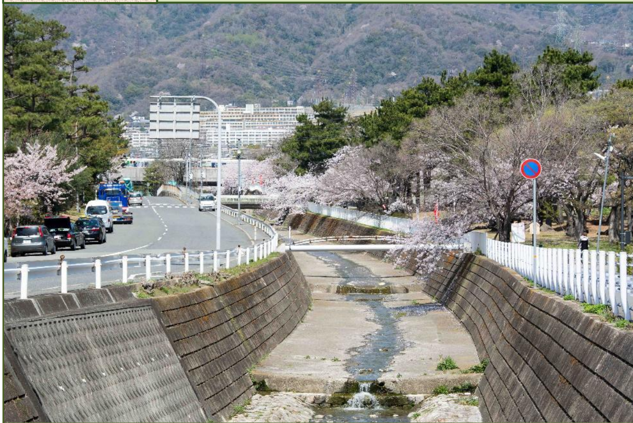
写真-1 国道2号・石屋川橋から石屋川を撮影（平成30年3月）
