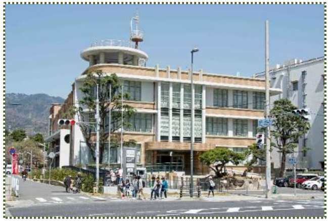
写真-8 耐震改修後の御影公会堂（平成 30 年 3 月撮影）
