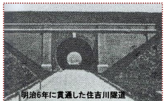
写真-7 住吉川隧道(『住吉川アルバム』から引用・加工)
