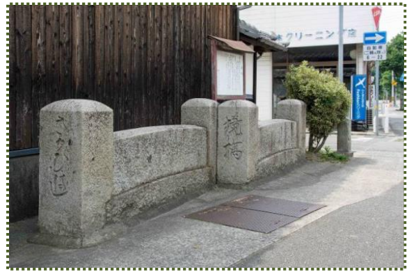
写真-2 道路脇に保存されている境橋の親柱と高欄
