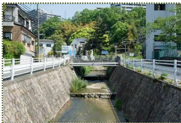
写真-4 石屋川に架かる上高羽橋
