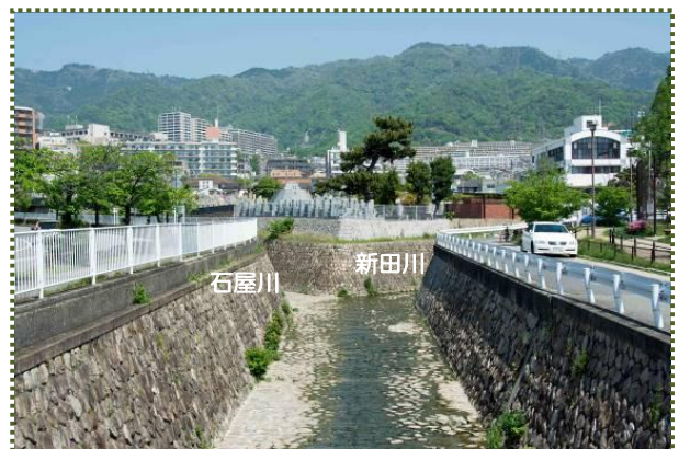
写真-2 令和元年 5 月、平野橋から撮影
