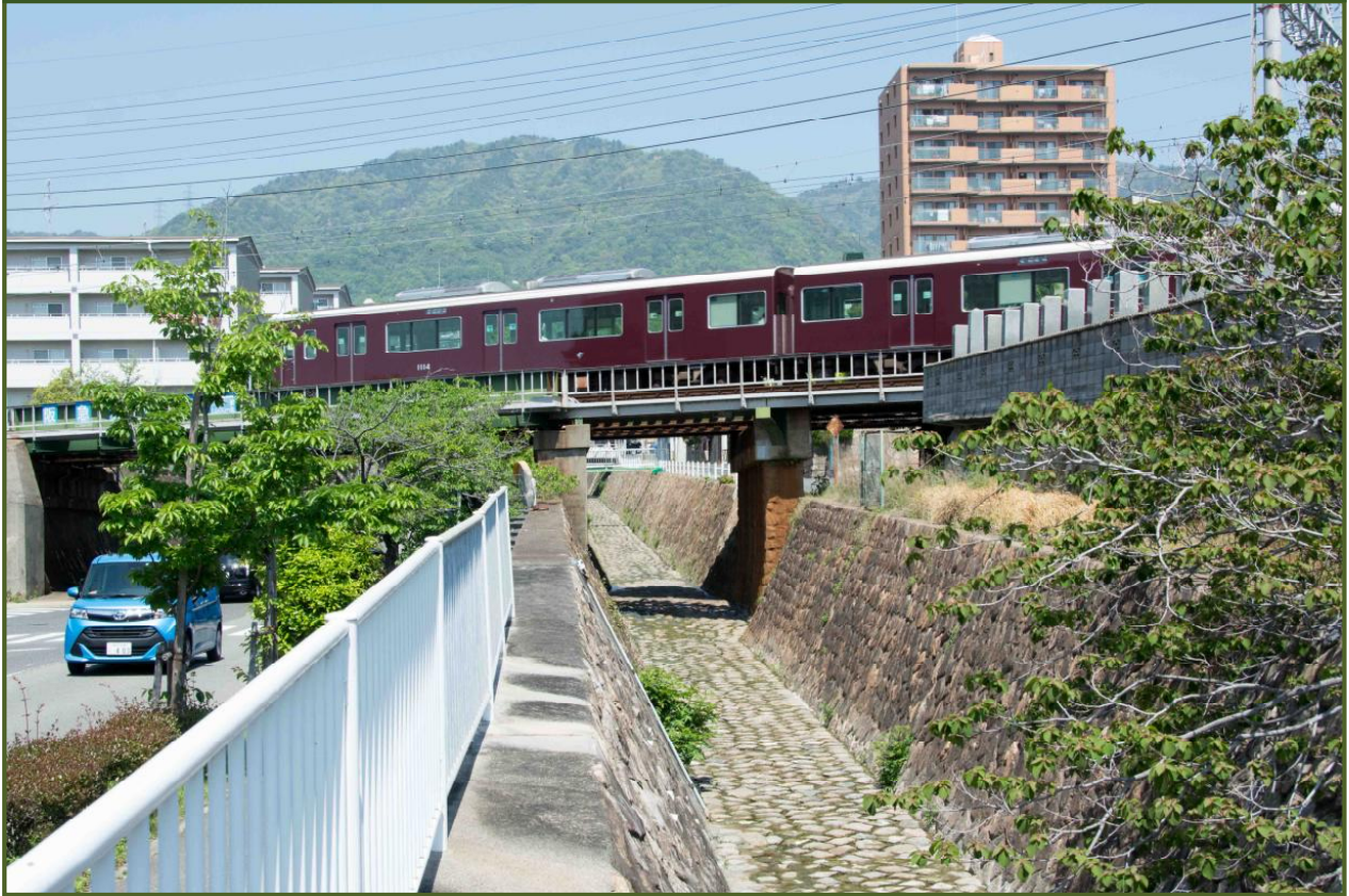
写真-1 阪急橋梁下を流れる石屋川（令和元年5月）
