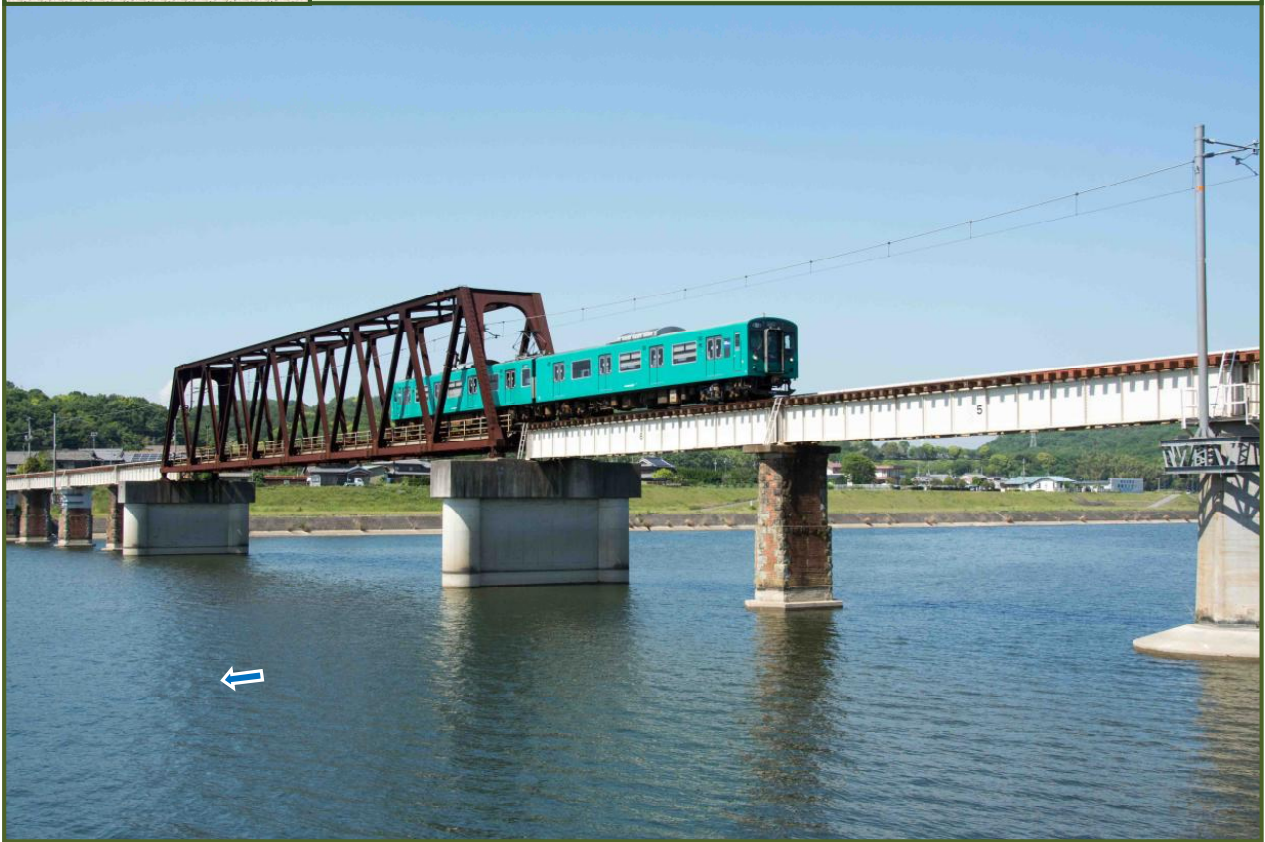
写真-1 JR 加古川線・第二加古川橋梁（令和2年5月撮影）
