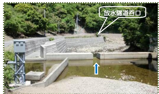
写真-4 岩蔵岩井堰
