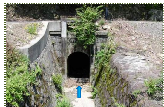
写真-5 放水隧道呑口
