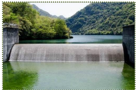
写真-2 大城池洪水吐越流部
