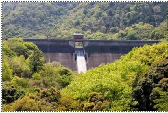
写真-12 鮎屋川ダム遠望
