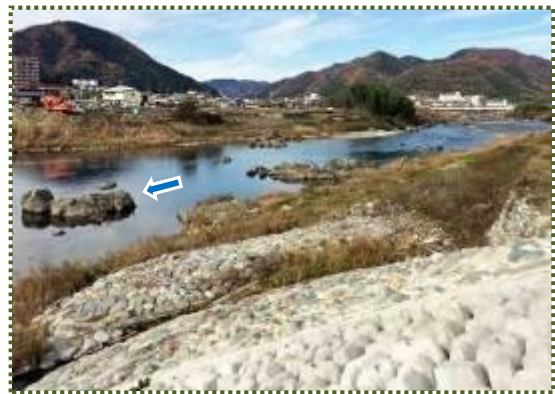
写真-5 左岸側の突堤
