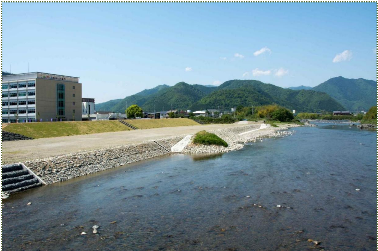
写真-6 平成 26 年 5 月時点の工事中の揖保川（2 ヶ所の突堤がよくわかる）
