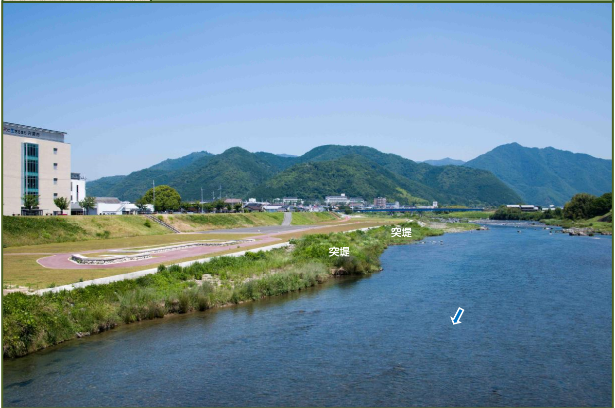
写真-1 宍粟橋から揖保川を撮影（令和3年6月）
