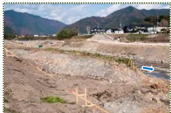
写真-3 低水護岸の丁張から突き出た突堤
