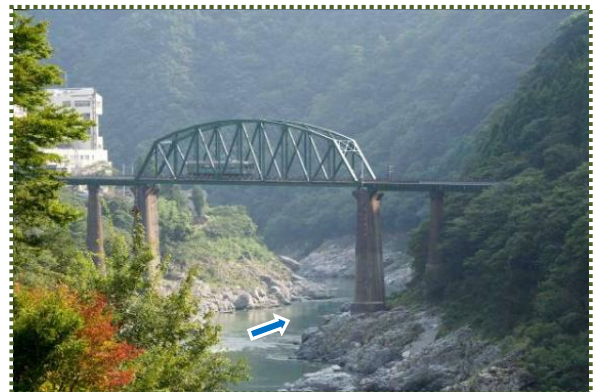
写真-4 小歩危(「歩危茶屋」から土讃線・第二吉野川橋梁を撮影)
