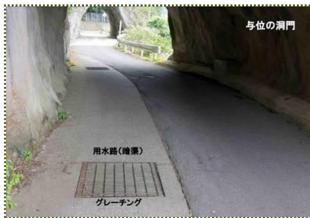
写真-6 洞門内の田井への送水路(暗渠)
