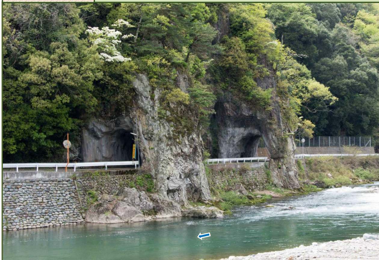
写真-1 揖保川左岸堤防から「与位の洞門」を撮影（平成28年4月）
