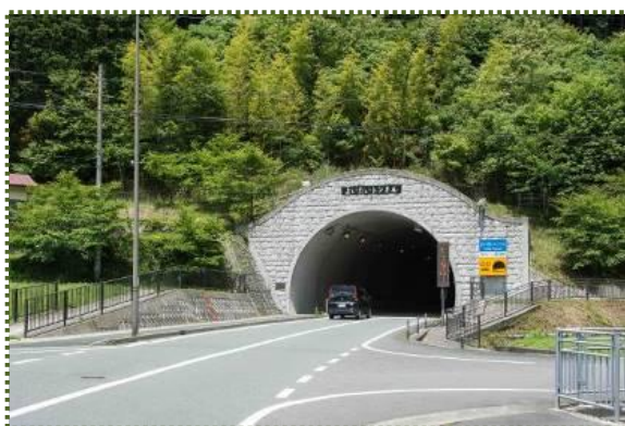
写真-12 よいたいトンネル南側
