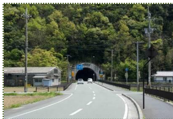
写真-13 よいたいトンネル北側
