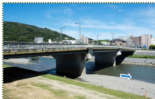
写真-2 国道176号・呉服橋
